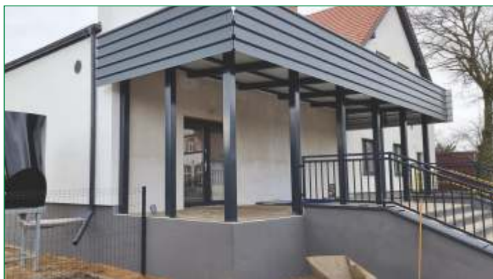
Przed wejściem do pomieszczeń świetlicy stanął piękny taras, który śmiało może być wykorzystywany podczas letnich wydarzeń przez korzystających z obiektu.
