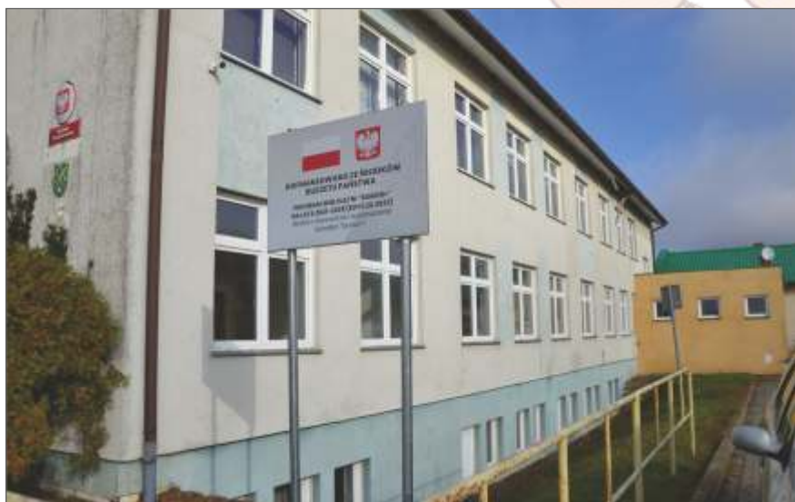
W tej części poszkolnego obiektu w Pluskowężach powstaje siedziba Dziennego Domu Seniora + „Przystań Seniora – Pluskowęsy”.
