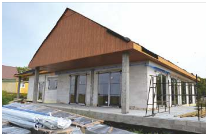
W sąsiedztwie starej świetlicy w Brąchnówku, wcale w niedługim czasie wyrósł ku uciechu mieszkańców nowy obiekt świetlicy. Pierwszy etap inwestycji powoli zmierza ku zakończeniu.
