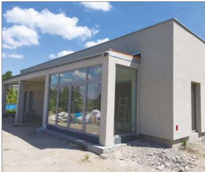
Zmiany przy obiekcie są już widoczne. Nowa elewacja i nowe witryny okienne na pewno wyróżnią obiekt w najbliższym otoczeniu.
