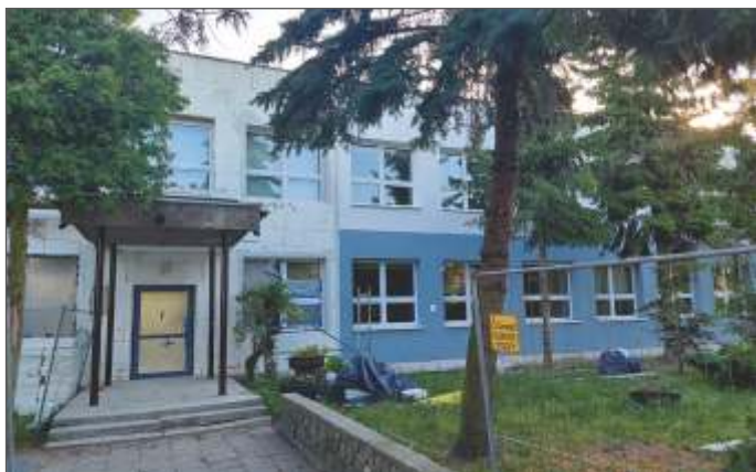
Budynek szkolny w Głuchowie się zmienia. Świadczy o tym ostatnio wykonywana elewacja zewnętrzna ścian.
