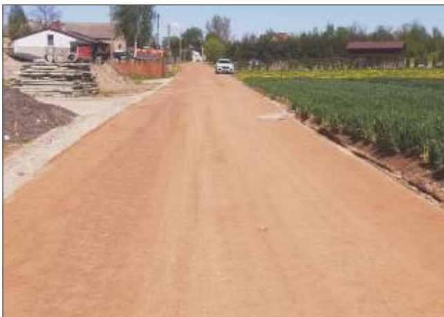
Przebudowa drogi gminnej w miejscowości Skąpe
