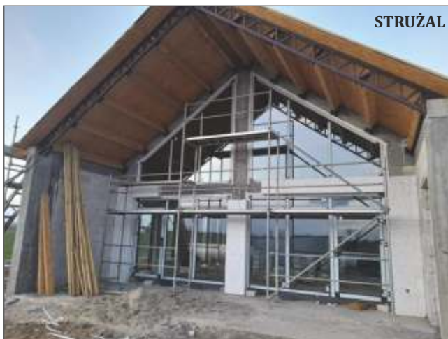
W budynku zamontowano okna, przez które już niedługo będzie można popatrzeć każdą porą roku na piękne Jezioro Chełmżyńskie.
