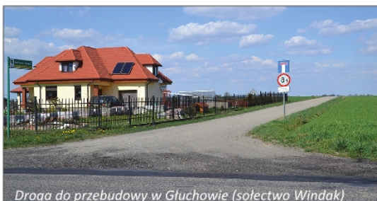
Droga do przebudowy w Głuchowie (sołectwo Windak)
