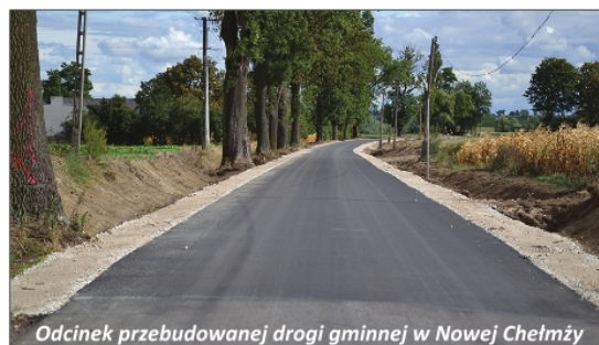
Odcinek przebudowanej drogi gminnej w Nowej Chełmży
