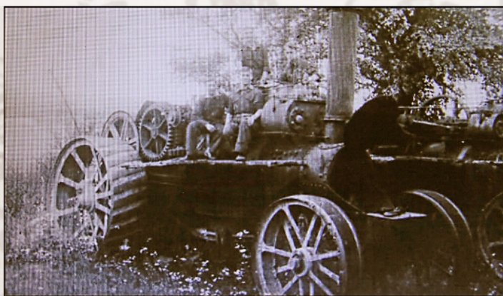
Lokomobila z fabryki braci Lohrke (Chełmińskie Przedmieście)
