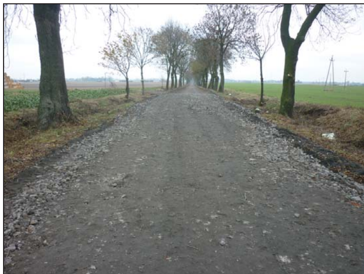
Na zdj. Inwestycja drogowa jest w trakcie.
