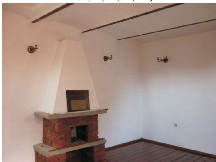
* Zelgno - na ukończeniu są roboty remontowe budynku gospodarczego za „pastorówką” w Zelgnie. Budynek pełnić będzie siedzibę Pracowni Rękodzieła Ludowego „MALWA” prowadzonej przez Centrum Inicjatyw Kulturalnych Gminy Chełmża, a jednocześnie będzie uzupełnieniem powstającego tutaj Centrum Kultury i Tradycji „Świat Bocianów”. K.O.
