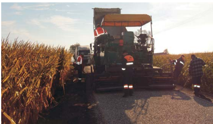
Remontowana droga w miejscowości Liznowo
