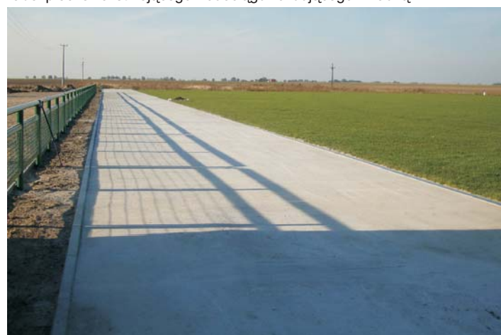
* Kończewice - w Kończewicach realizowany jest II etap budowy boiska, który obejmuje wykonanie ogrodzenia i oświetlenia terenu, przyłącza wodociągowego, dróg dojazdowych i miejsc utwardzonych, chodników, bieżni prostej czterotorowej, montaż trybun z siedziskami, bramek z siatkami, wiat stadionowych dla zawodników oraz elektronicznej tablicy wyników. Wartość robót 969.703,59 zł, z czego w 2010 r. zostanie zrealizowana i zapłacona część zadania na kwotę 200.000 zł, dokończenie robót tj. wykonanie drogi dojazdowej do terenu za boiskiem w 2011 r. Firma Ogrodnicza Leśniewscy Architektura zieleni z Chełma, wykonawca I etapu boiska w Kończewicach wykonuje zabiegi pielęgnacyjne płyty trawiastej.
