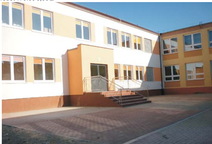
* Zelgno - ukończono prace budowlane przy rozbudowie szkoły podstawowej w Zelgnie. Roboty wykonała firma PUM z Grudziądza na kwotę 1.790.000 zł, Wybudowany został również plac szkolny - wartość robót ok. 28.00,00 zł.
