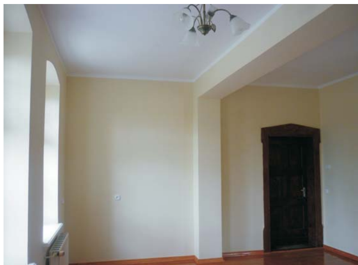
* Zelgno - Trwają prace przy odnowie wsi w Zelgnie. Roboty wykonuje firma SOEN z Grudziądza za kwotę 410. 000 zł. Prace w budynku „pastorówki” zostały ukończone.
