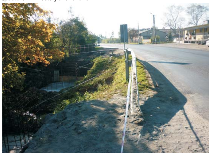
* Zelgno - Termin dokończenia kładki dla pieszych, po aneksowaniu umowy, do 15.11. 2010 r. Wykonano przecisk sterowany dla zabezpieczenia istniejącego wodociągu kolidującego z kładką.
