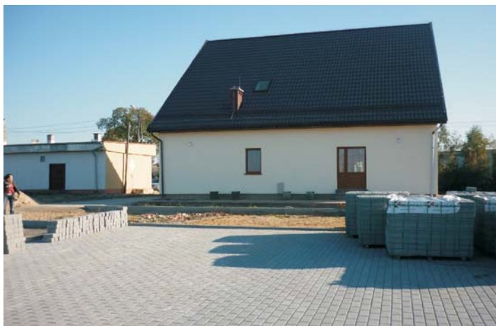
* Dźwierzno - trwają roboty wykończeniowe terenu przy świetlicy w Dźwierznie, roboty wykonuje firma Constans z Golubia- Dobrzyń, wartość robót 170.00 0,00 zł
