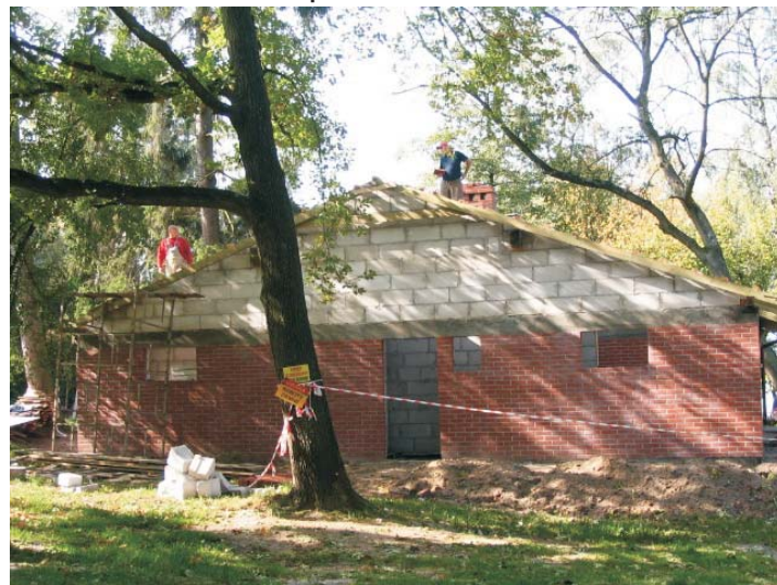
W trakcie budowy są prysznice i plac zabaw.
