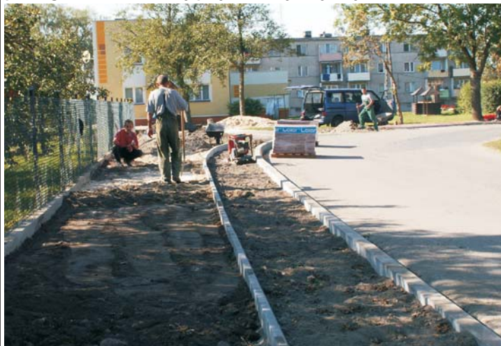
Budowa chodników i terenów zielonych w Kończewicach
