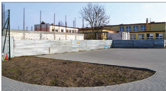
Obecne otoczenie budynku szkoły już niebawem uzupełni nowa sala sportowa, która z istniejącym boiskiem stanowić będzie nowoczesny kompleks sportowy.
