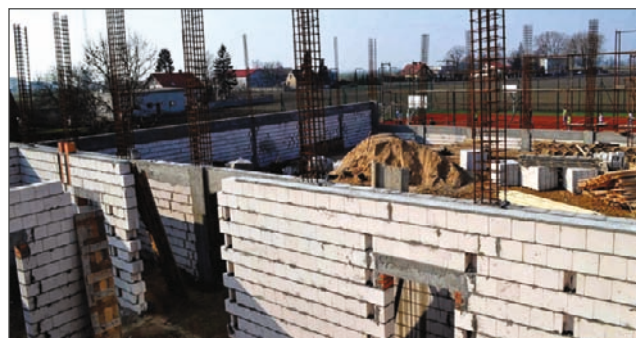
Trwa budowa murów przyszłej sali sportowej.
