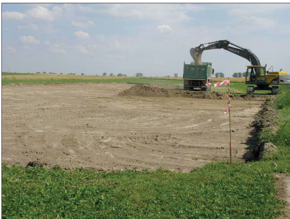
Na zdj.: Przy budowie kompleksu rozpoczęły się prace ziemne mające na celu przygotowanie gruntu pod inwestycję.
