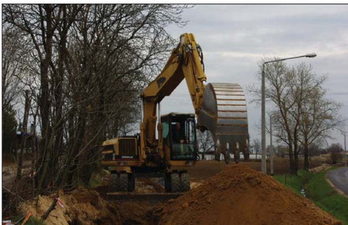
Budowa kanalizacji na terenie miejscowości Kończewice.
