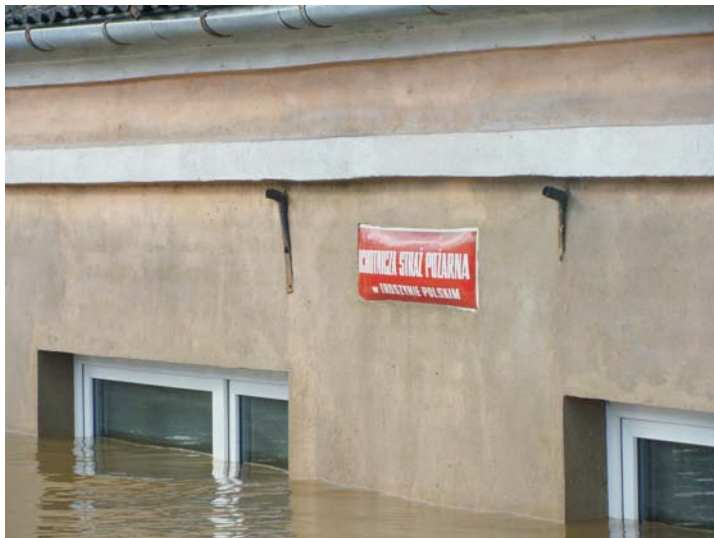
Całkowitemu zniszczeniu uległ wyremontowany budynek Ochotniczej Straży Pożarnej w Troszynie Polskim wraz z jego wyposażeniem.
